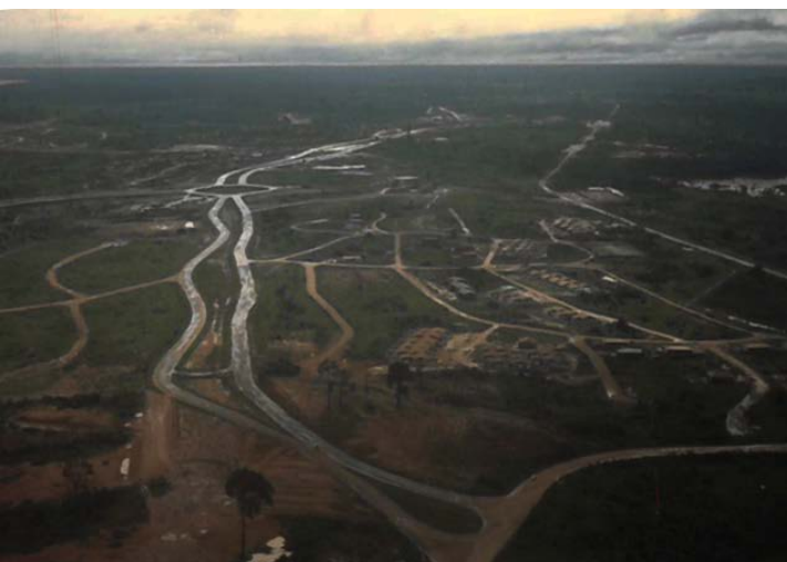
Il. 6: Vista aérea da implantação da Nova Marabá seguindo o PEUM, em julho de 1981. Fonte: YOSHIOKA, 1986.
