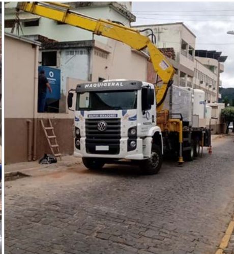
Il. 10: Instalação de novo gerador no HSVP a partir de sua fachada voltada para a Avenida Fasbender, demandando interdição temporária da via.
