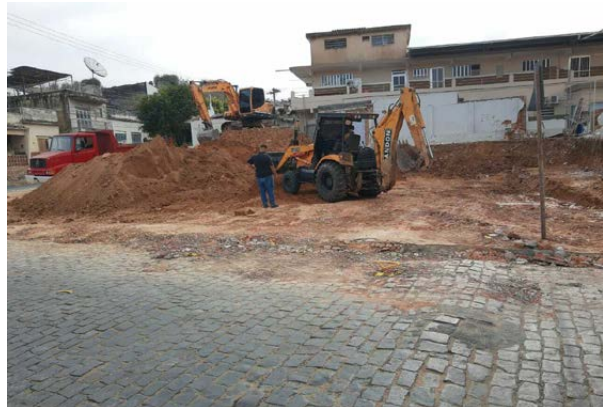
Il. 13: Movimentação de terra em terreno onde ocorrerá expansão do HSVP. Fonte: Acervo das Autoras, 2022.
