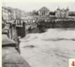
Queda da ponte (12.02.1922).
