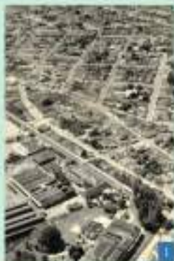
Vista aérea parcial
