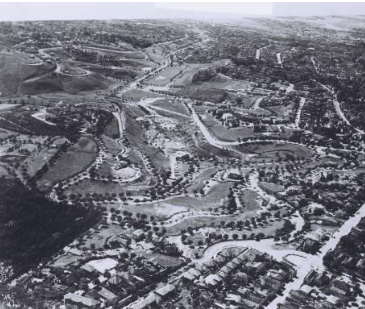
Il. 4: Sistema viário do bairro ainda recém aberto. No centro da foto, o fundo do vale onde seria construído o estádio. No canto inferior direito, o trecho final da Av. Paulista no encontro com a Av. Angélica.
