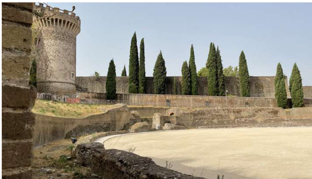
Il. 6: Anfiteatro romano de Bleso en Tivoli (II siglo d.C.). Derribado parcialmente en la época medieval, la intervención consistió en la realización de un núcleo de servicios, en la ejecución de un suelo firme para la arena, destinada a la presentación de espectáculos, y en la consolidación y restauración de las estructuras del graderío. Proyecto: M. M. Segarra Lagunes, con F. Cellini, 2008-19).
