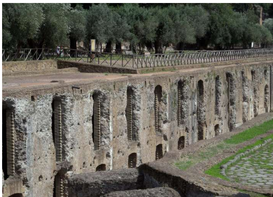
Il. 1: Conjunto llamado “Cento Camerelle” en la Villa del emperador Adriano en Tívoli (Italia), para el cual se elaboró el proyecto de restauración y reutilización como depósito de material arqueológico. Para ello se efectuaron reintegraciones de los flancos de las aberturas que permitieron colocar rejas, completamente invisibles desde el exterior. La excavación dio también lugar al descubrimiento de dos calzadas de acceso a la villa: una de servicio, conectada con los pasajes subterráneos, y otra a un nivel más alto, de tipo ceremonial. Proyecto: M. Manieri Elia, con G. Manieri Elia, M. M. Segarra Lagunes, 1997-2002. Fuente: Archivo M. Segarra Lagunes.
