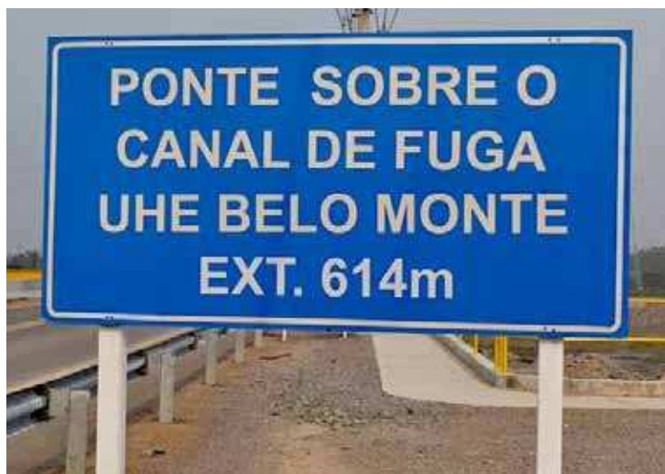
Foto 10 – Visita ao canal de fuga
