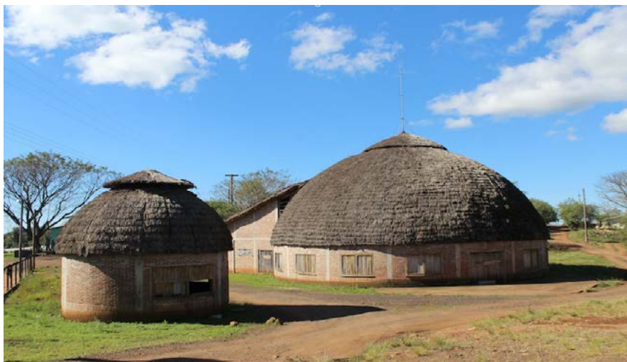
Figura 6 - Módulo maior com extensão ao fundo
