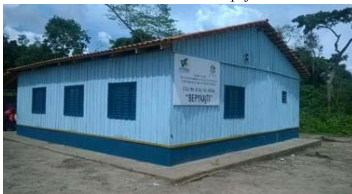
Imagem 3: Fachada da Escola Municipal de Ensino Fundamental Indígena Bepkurwyti, localizada na aldeia Tepdjàti
