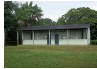
Figura 5: Sala de sala de aula da escola Tuyuka. São Pedro (2013).
