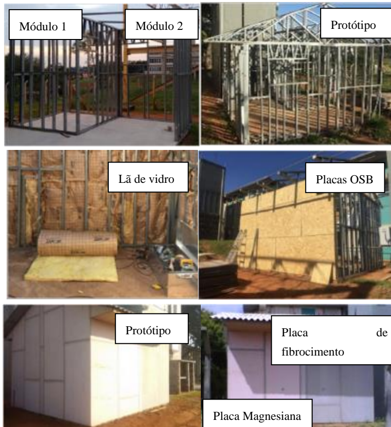
Figura 1: Etapas construtivas do protótipo do Light Steel Frame.
