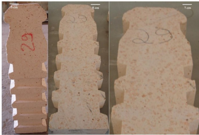
Figura 9: Âncora de parede 29 sob suspeita com velocidade menor no ensaio de ultrassom
