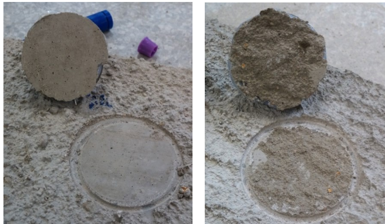
Figura 4: Pastilhas após extração. Rompimento na interface chapisco/substrato (esq.) e rompimento na argamassa de chapisco (dir.)
