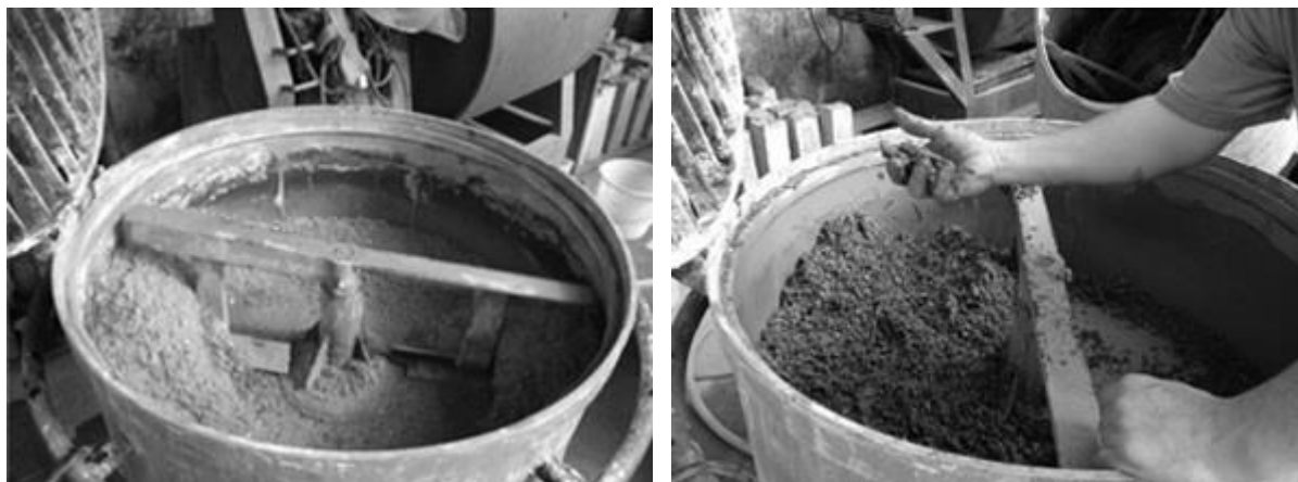
a) mistura de materiais na argamassadeira
