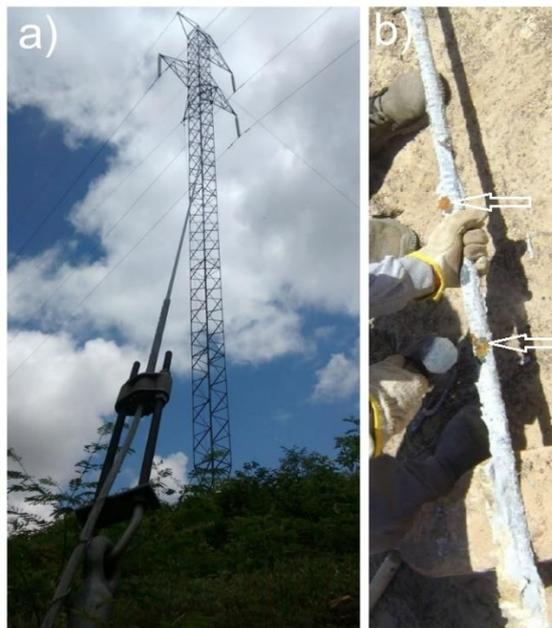
**Figura 1:** Fotos ilustrativas: (a) de uma das torres estaiadas de uma linha de transmissão de energia elétrica instalada no nordeste do Brasil; (b) do problema de corrosão em determinadas regiões (setas) de uma das hastes enterradas por cerca de 10 anos.
