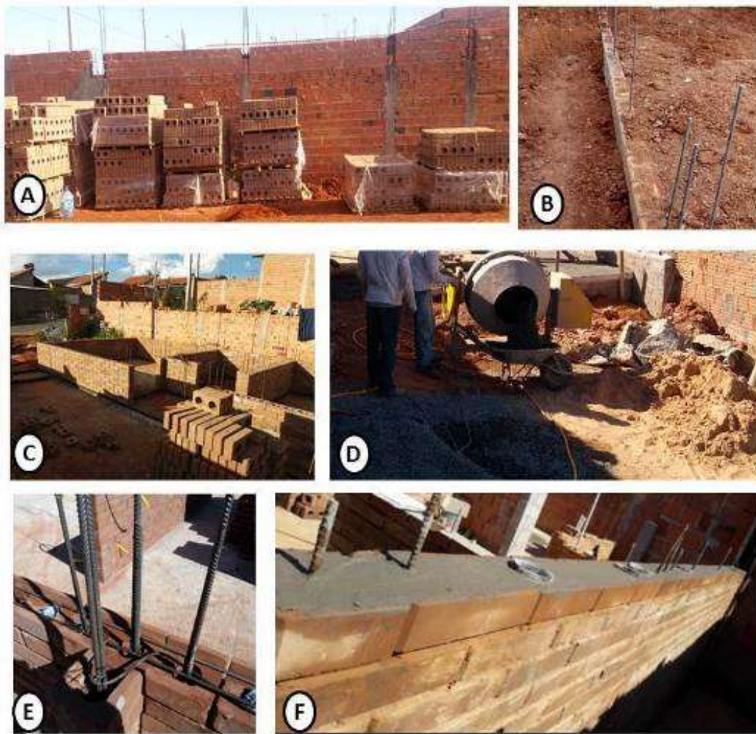
Figura 10: Etapas de produção da alvenaria com tijolo solo cimento. (a): estocagem dos tijolos na obra; (b): colocação da armação dos pontos de grauteamento; (c): elevação das fiadas; (d): produção do concreto; (e): colocação das armaduras nas canaletas; (f): concretagem das canaletas.
