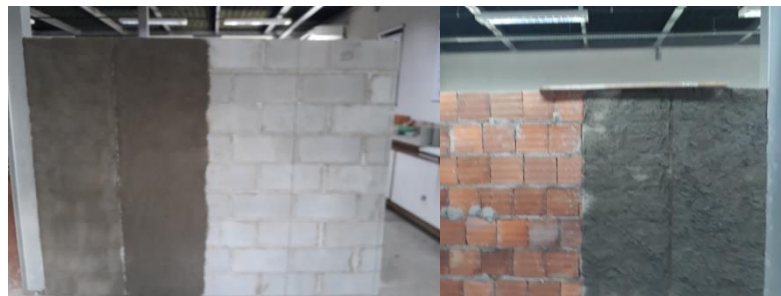
Figura 7: Paredes de vedação sendo chapiscadas: bloco concreto (esquerda) e cerâmico (direita).
