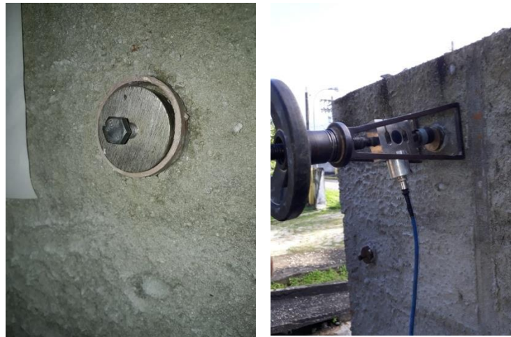
Figura 6: Colagem da peça metálica sobre a superfície da camada de epóxi (preenchimento da cavidade do tudo de PVC) [sobre o chapisco (esquerda)]; posicionamento do aderímetro (direita).
