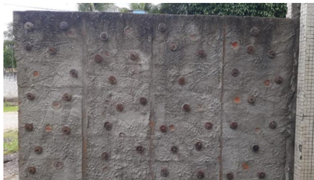
Figura 5: Parede de alvenaria de blocos cerâmicos com as Famílias de chapisco com alguns corpos de provas.
