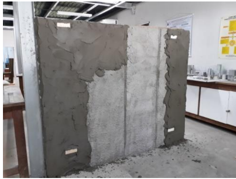
Figura 8: Substrato com argamassa de revestimento sendo aplicado.
