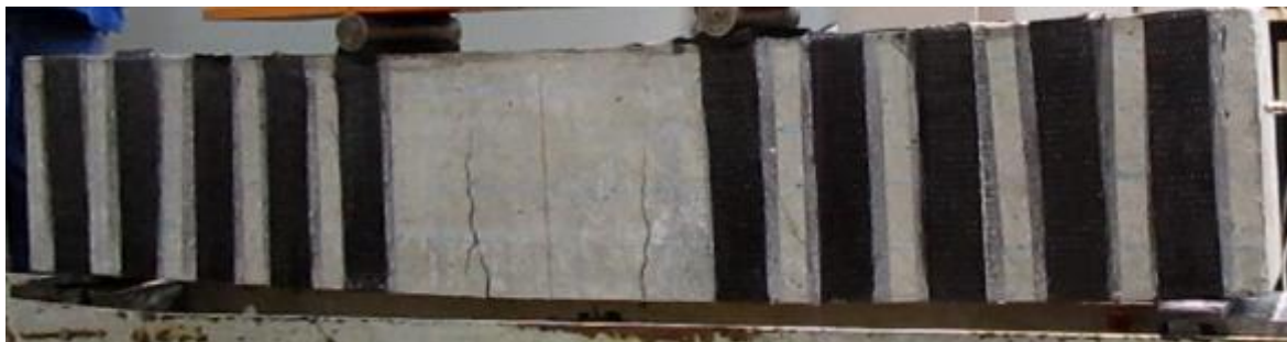
Figura 12: Viga reforçada com CFRP.
